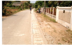
โครงการก่อสร้างวางระบายน้ำคอนกรีตเสริมเหล็ก รูปตัวยูพร้อมฝาดปิด หมู่ที่ 9 บ้านแม่ตำบุญโยง
