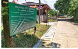
โครงการก่อสร้างวางระบายน้ำรูปตัวยู พร้อมฝาดปิด หมู่ที่ 17 บ้านแม่ไก่โทกหวาก
