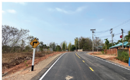
โครงการก่อสร้างถนนลาดยางพาราเอสพีลท์ติกคอนกรีต ถนนชลประทาน-ซอยบ้านดง หมู่ที่ 2 บ้านแม่กาห้วยเคียน
