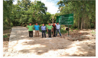
โครงการวางท่อคอนกรีตเสริมเหล็กพร้อมบ่อดัก และขยายถนน (ฝั่งปากน้ำต้นหมนาง-มะม่วงจุ่ม) หมู่ที่ 9 บ้านแม่ตำบุญโยง
