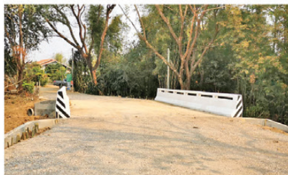
โครงการก่อสร้างสะพานคอนกรีตเสริมเหล็ก หมู่ที่ 17 บ้านแม่กาโทกหวาก
