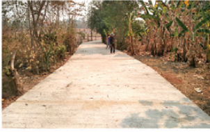
โครงการก่อสร้างถนนคอนกรีตเสริมเหล็ก ซอย 10 หมู่ที่ 15 บ้านเกษตรสุข
